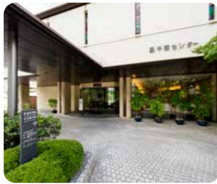
堀川通に面した裏千家センター正面玄関
