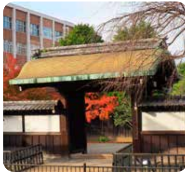
銅板と真鍮板で葺かれた平唐門(青天門)
