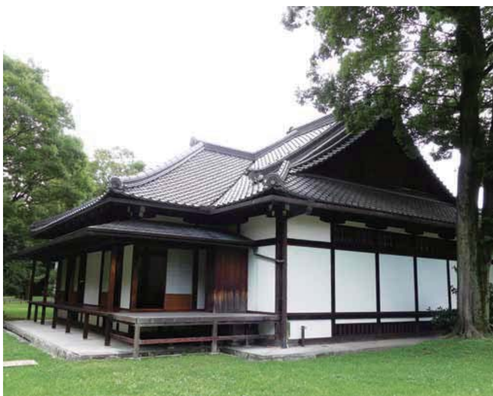
閑院宮邸跡収納展示館東南外観
